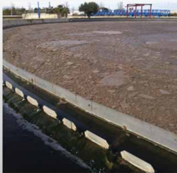
Decantador afectado por bulking
